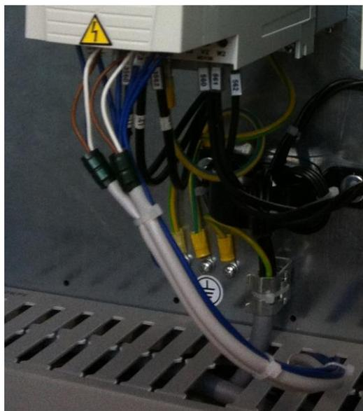
Il montaggio dei componenti che possono emettere disturbi elettromagnetici, deve essere il più possibile separato dagli altri componenti (es. in moduli diversi del medesimo QE e/o effettuando posizionamenti adeguati).
